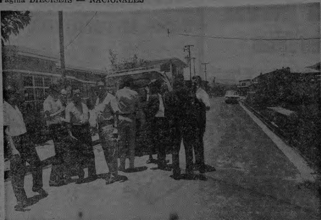
Los señores regidores explican a los periodistas el costo y el tiempo en que fue construida esta importante vía de comunicación ubicada en el Barrio Hispano, rehabilitando así a
